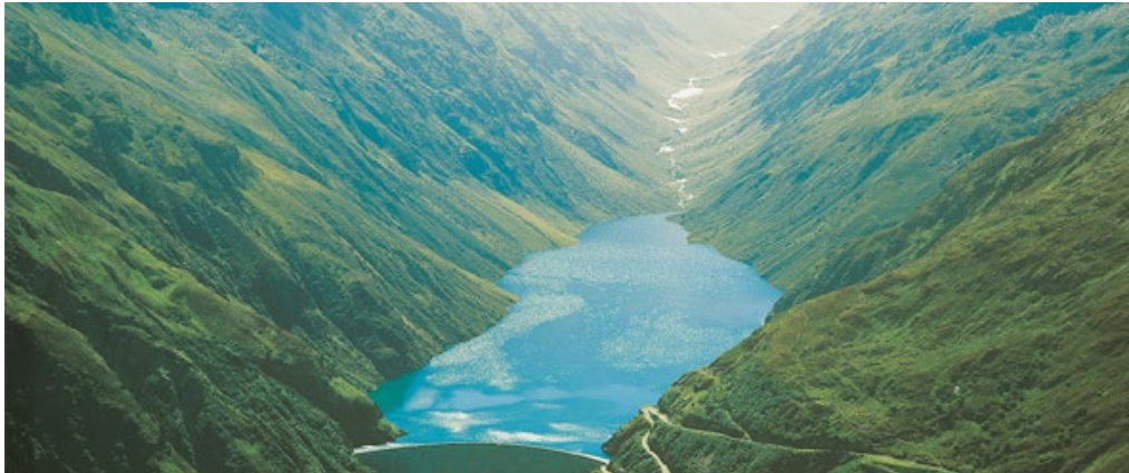
Staumauererhöhungen Laj da Curnera
