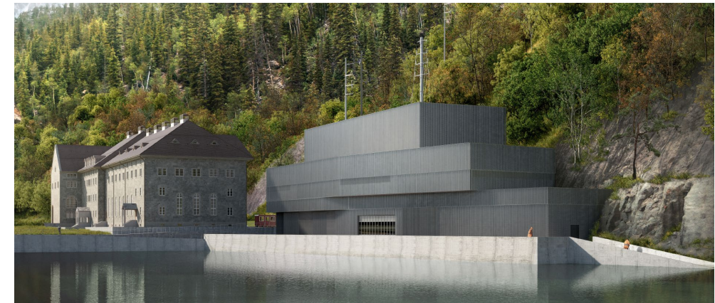
Neue Kraftwerkszentrale Ritom: 150 GWh
