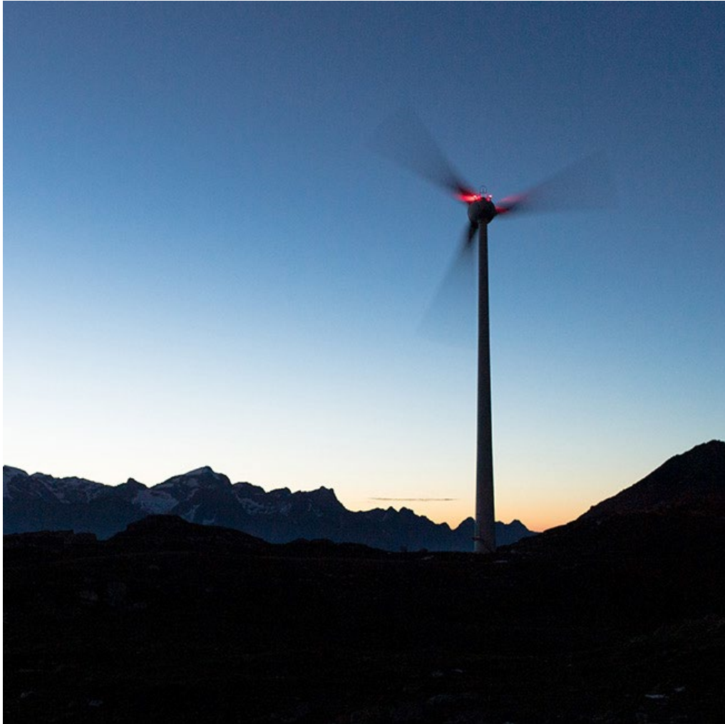
Windpark Gütsch ob Andermatt
