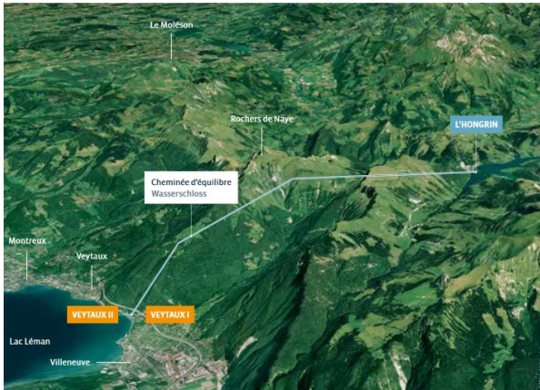
40 Pumpspeicherkraftwerke wie Hongrin-Genfersee
