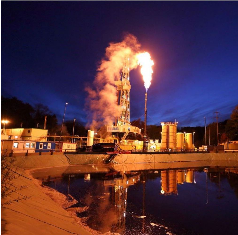
Ehemaliges Geothermieprojekt St.Gallen
