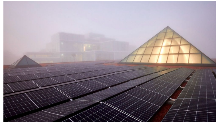
Rund 90'000 PV-Anlagen wie HSG-Dach
